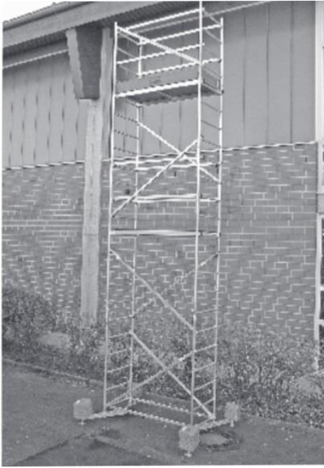
Obrázok ukazuje hotovú montáž lešenia s prvým a druhým poschodím a 20 stabilizačnými závažiami.
