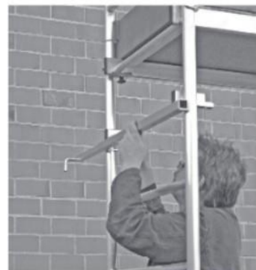
Obrázok ukazuje montáž stabilizačnej sady. Ďalšie podrobnosti v kapitole 4.7.
